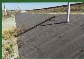
法面・道路脇
